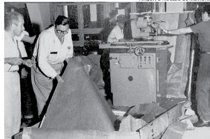
Montagem dos primeiros laboratórios do ITUC (1959)
