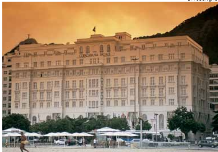
Fachada do hotel projetado pelo famoso arquiteto Joseph Gire
